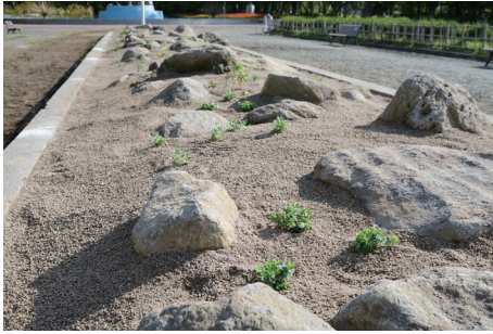
石組みの間に培養土が敷き詰められ、最後に 花の苗を植栽してロックガーデンが完成。
